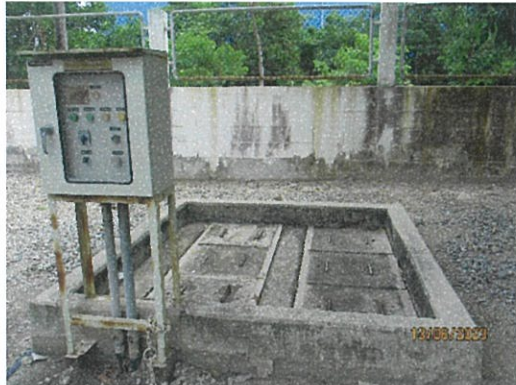
ภาพที่ 2-20 ระบบบำบัดน้ำเสียสำเร็จรูป
