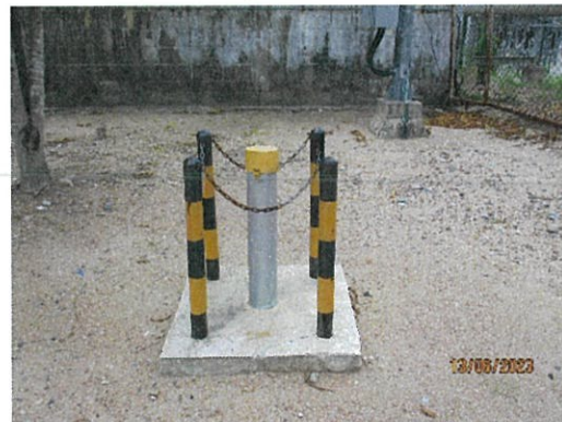
ภาพที่ 2-24 บ่อสังเกตการณ์ (Monitoring Well)
