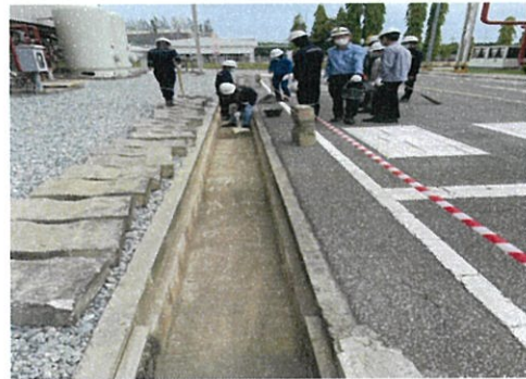
ภาพที่ 2-13 การขุดลอกตะกอนภายในรางระบายน้ำของโครงการ
